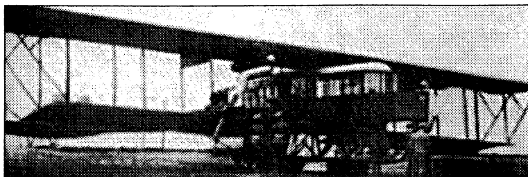
Окончательный вариант «Русского Витязя» («Гранда») с четырьмя 100-сильными двигателями «Аргус» (1913 г.).
